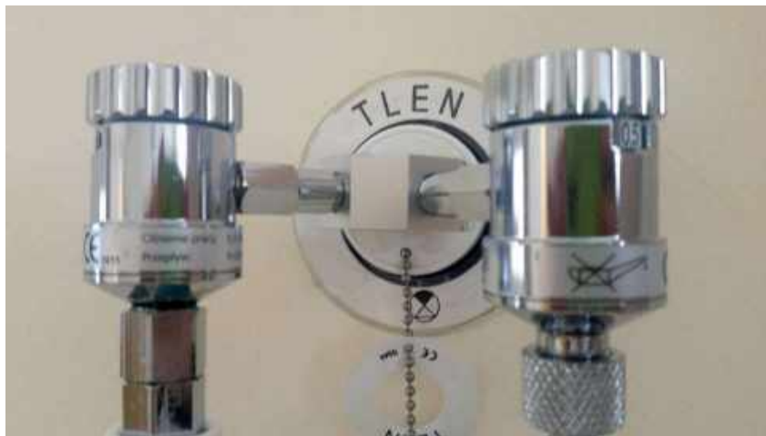
Rycina 13. Dwa niezależne reduktory tlenu z różnym zakresem przepływu zasilane z jednego punktu poboru tlenu. Dzięki takiemu rozwiązaniu z jednego źródła tlenu może korzystać dwóch chorych.
